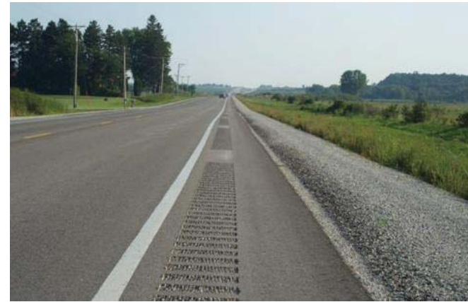
Edge Line Rumble Strips
